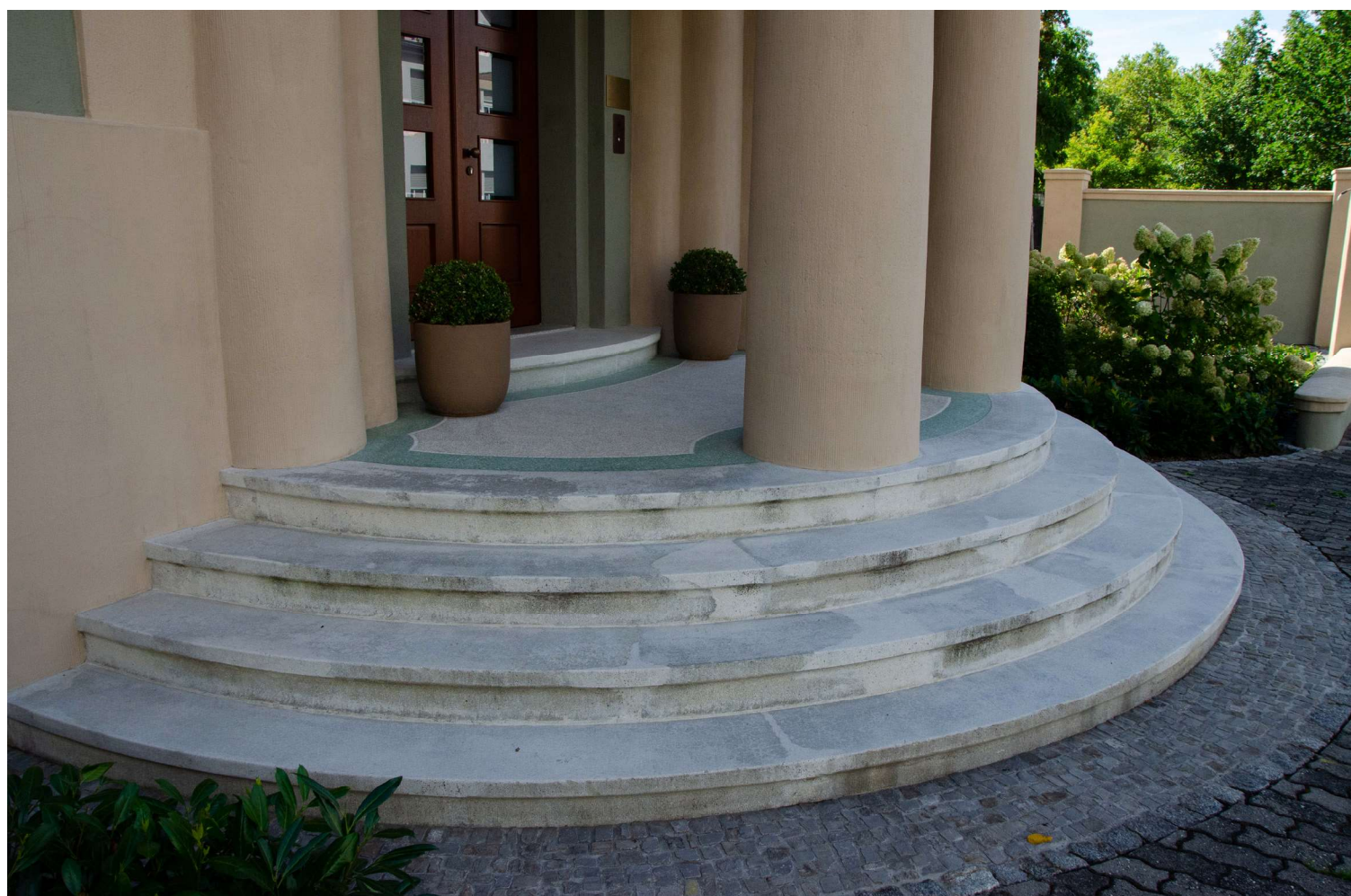
Detail: Rekonstruktion der Terrazzoflächen
