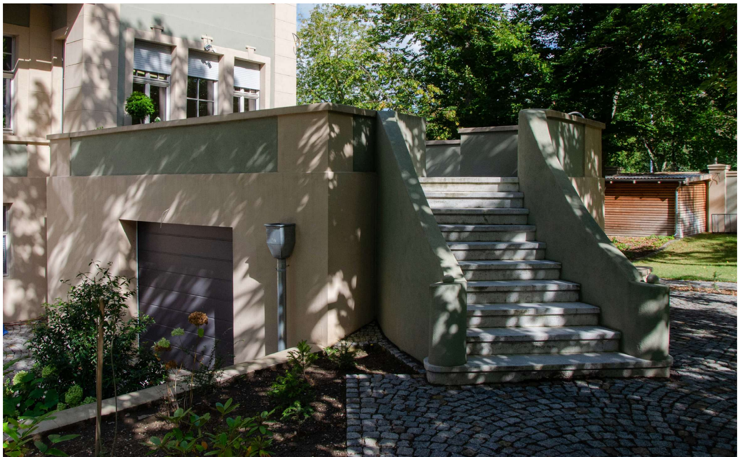
Garage/Terrasse mit proportional-verzogener Terrazzotreppe
