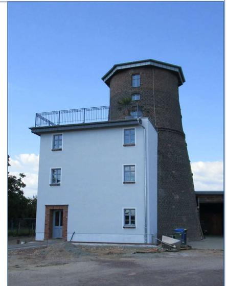
Die Mühle in Mildensee ist neben der Ziebigker Mühle die einzig erhaltene Turmwindmühle im Dessauer Stadtgebiet. Der mehrgeschossige Ziegelbau mit leicht parabelförmiger Bauweise wurde 1888 errichtet und später mit Dampfkraft betrieben. Der einzeln stehende Bau ist auf Grund seiner städtebaulichen Wirkung weithin sichtbar, insbesondere von der Straße nach Sollnitz Im Bereich des Gewerbegebietes Mildensee.
