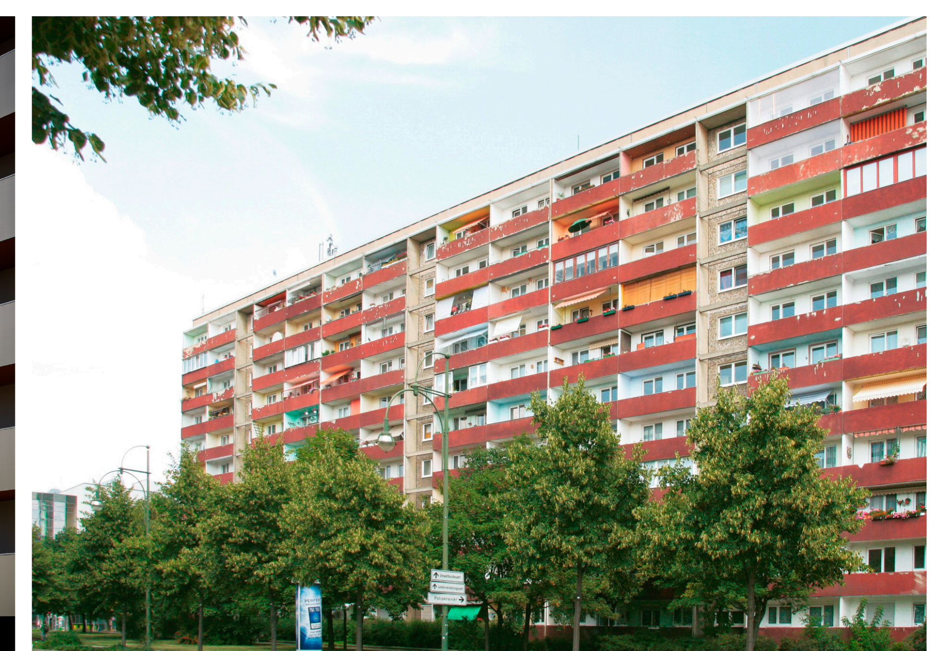
Wohnblock vor Sanierung
