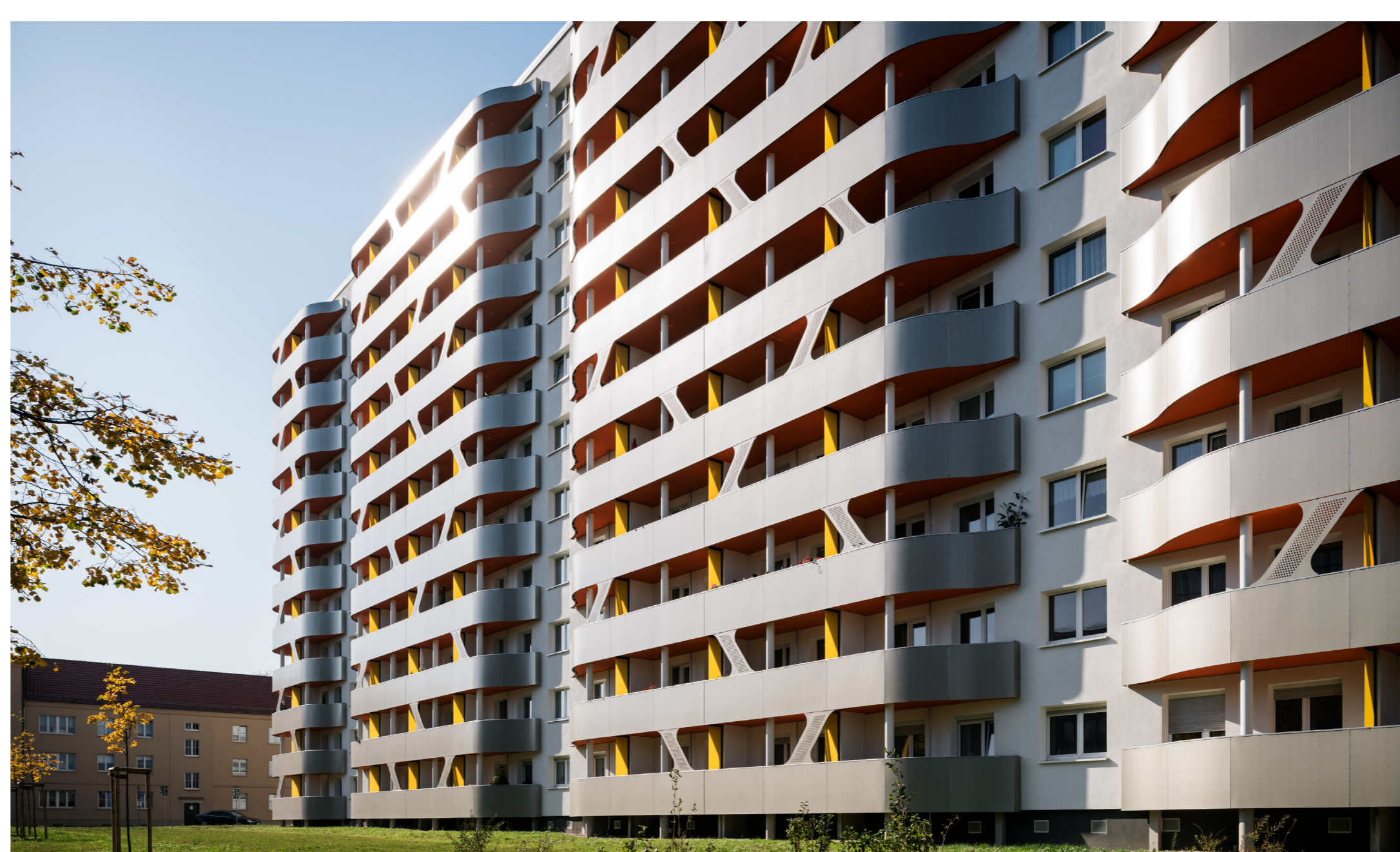
Wohnblock mit neuer Fassade
