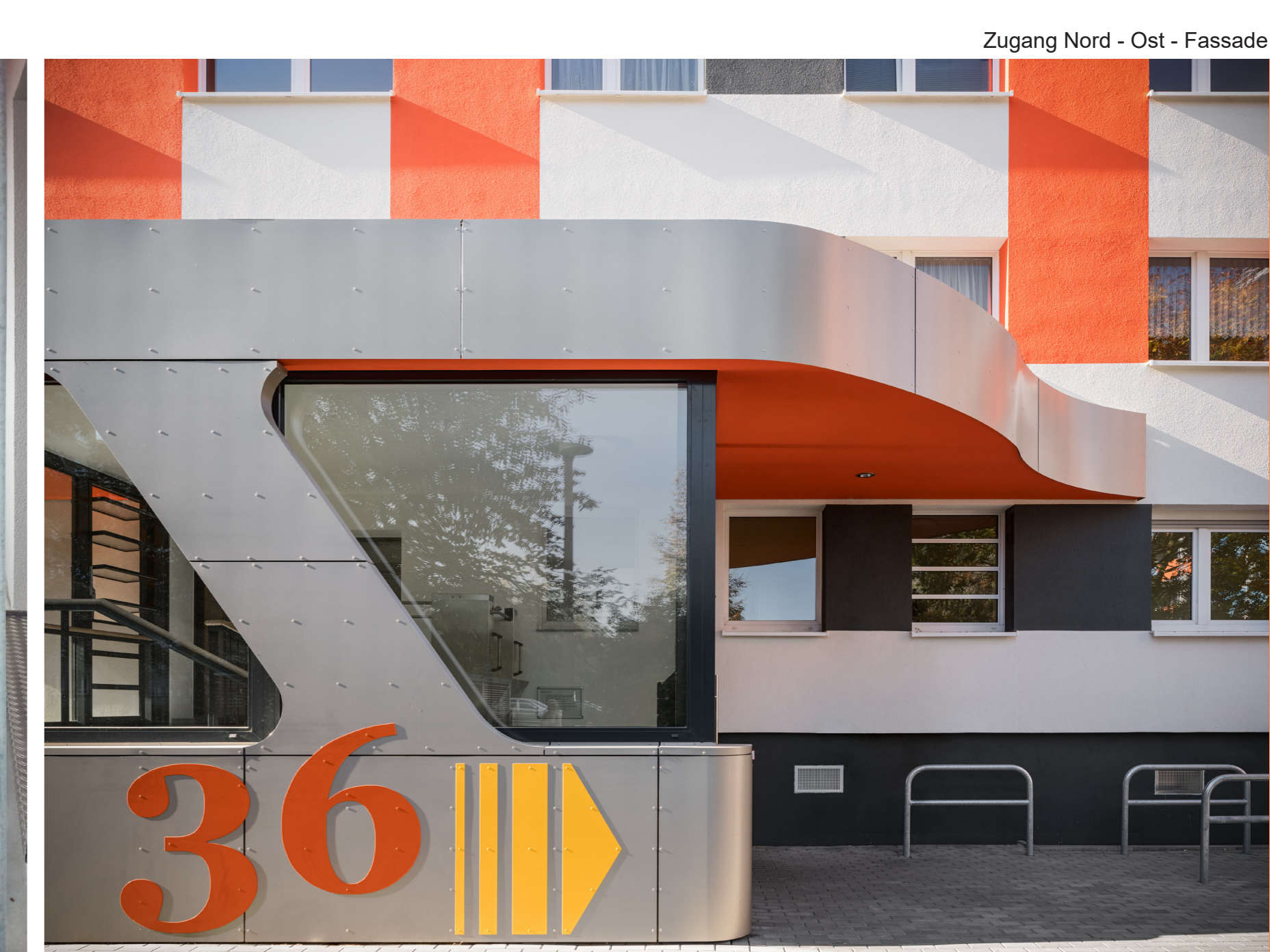
Zugang Nord - Ost - Fassade
