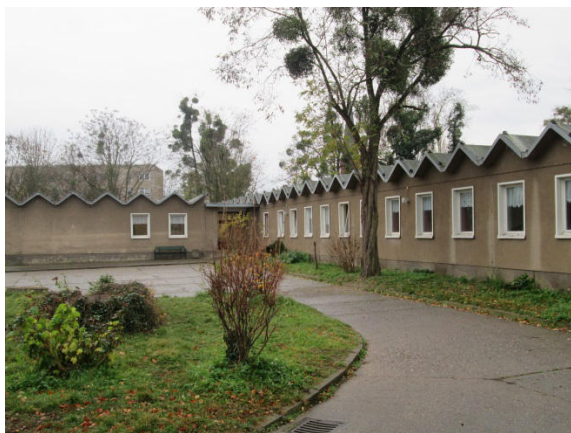
Nebengebäude der GS „Geschwister Scholl“
