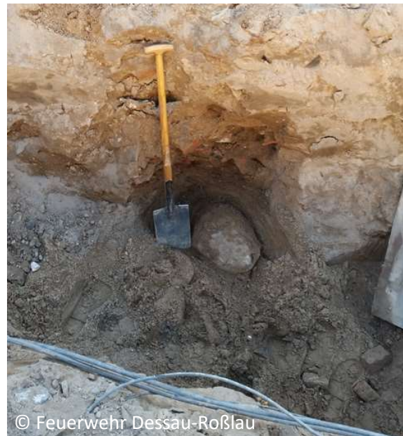
© Feuerwehr Dessau-Roßlau Die bei Bauarbeiten entdeckte Fliegerbombe.
