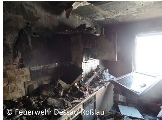
© Feuerwehr Dessau-Roßlau Die ausgebrannte Küche.
