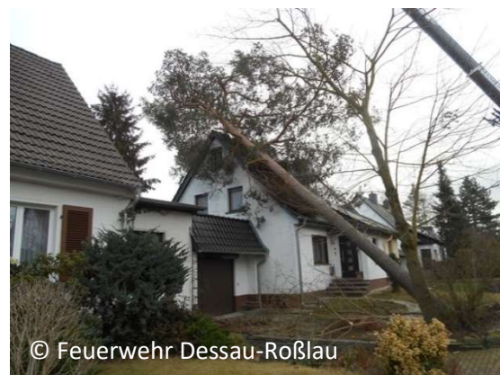
© Feuerwehr Dessau-Roßlau Ein Baum auf einem Hausdach.
