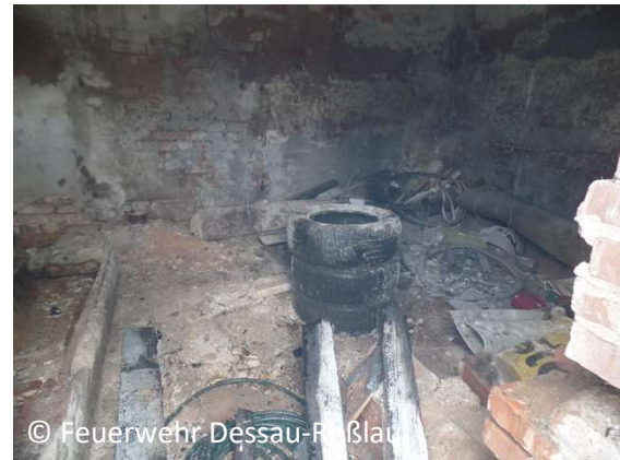
© Feuerwehr Dessau-Roßlau Der ausgebrannte Schuppen.
