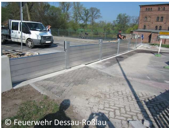
© Feuerwehr Dessau-Roßlau Mobiler Straßenverschluss an der Jonitzer Mühle.
