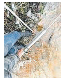
Bild 2 Ausmessen der Anstauhöhen hinter dem Verteilerbauwerk
