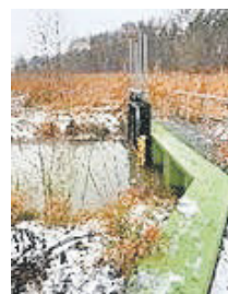
Bild 1 Anstauhöhe vor Verteilerbauwerk 70 cm
