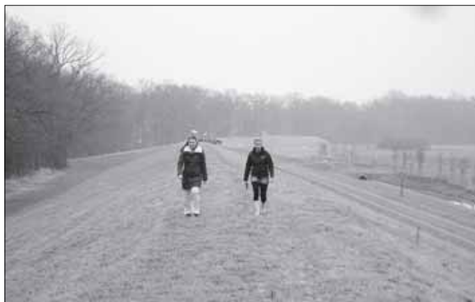
Deichkontrolle im Bereich Schwedenwall Nord.
