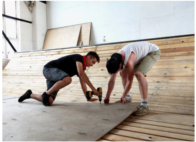
Holzplatten werden auf die Rampe geschraubt
